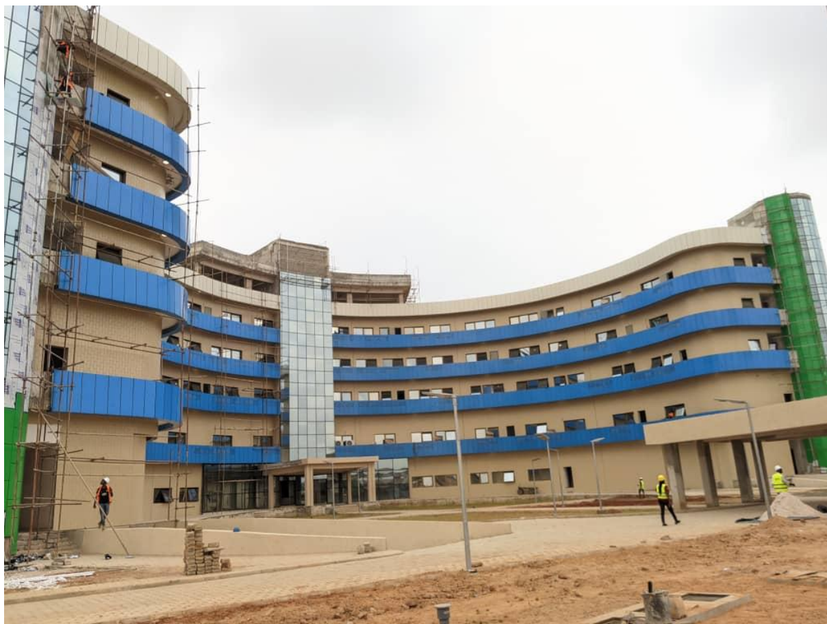
Vue d'ensemble du chantier à la date du 01/02/2024
